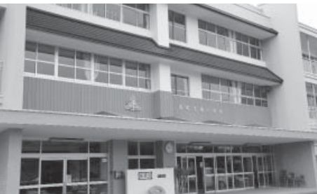
エアコンが設置された埴小
