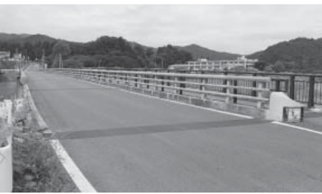
補修工事が行われた米山橋
